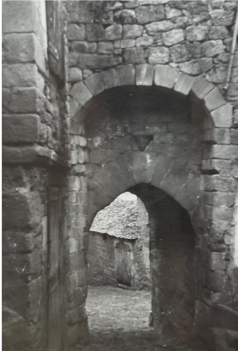
Fig.23 Sur ce deuxième cliché également inédit, on distingue très bien, entre les deux voutes, le socle de pierre qui supportait la statue d'une sainte ou saint protecteur de la porte. La maison située à gauche de la photo existe encore et est l'une des plus anciennes de Marzials. Cliché du fonds Balsan, collection de la Société des lettres, sciences et arts de l'Aveyron, 9 novembre 1946.
