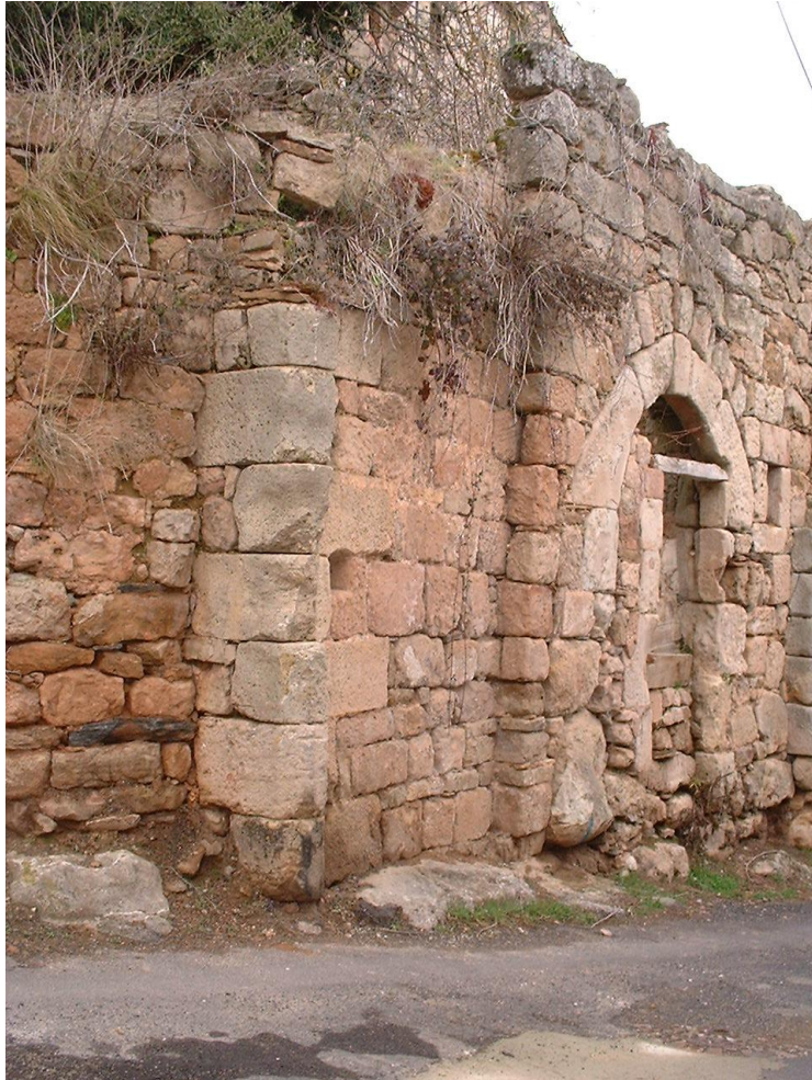
Fig.18 Vestiges de la porte de Jonau. La structure de la partie droite de la porte a subsisté jusqu'à nos jours avec le logement de la poutre qui permettait de renforcer la porte une fois celle-ci fermée. C'est l'unique vestige important qui subsiste encore de tous les remparts, tours et nombreuses portes fortifiées de Montjaux. Cette porte protégeait un ancien faubourg de Montjaux intégré dans ses remparts et permettait d'emprunter deux chemins importants : l'un allant vers « lo cap de la viala » et le quartier du château neuf et l'autre dévalant vers Roquegel puis la vallée du Tarn (photo Alain Bernat, 2008).
