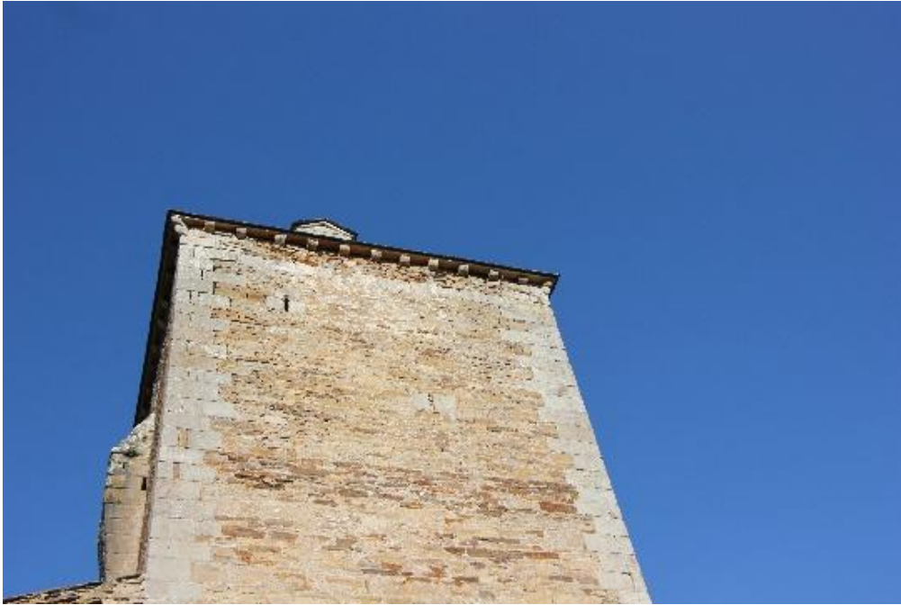
Fig.8 Façade ouest de la tour. Sur la façade nord, à gauche, on aperçoit le conduit maçonné des latrines du troisième niveau (photo Jean-Claude Trazic, 2019).
