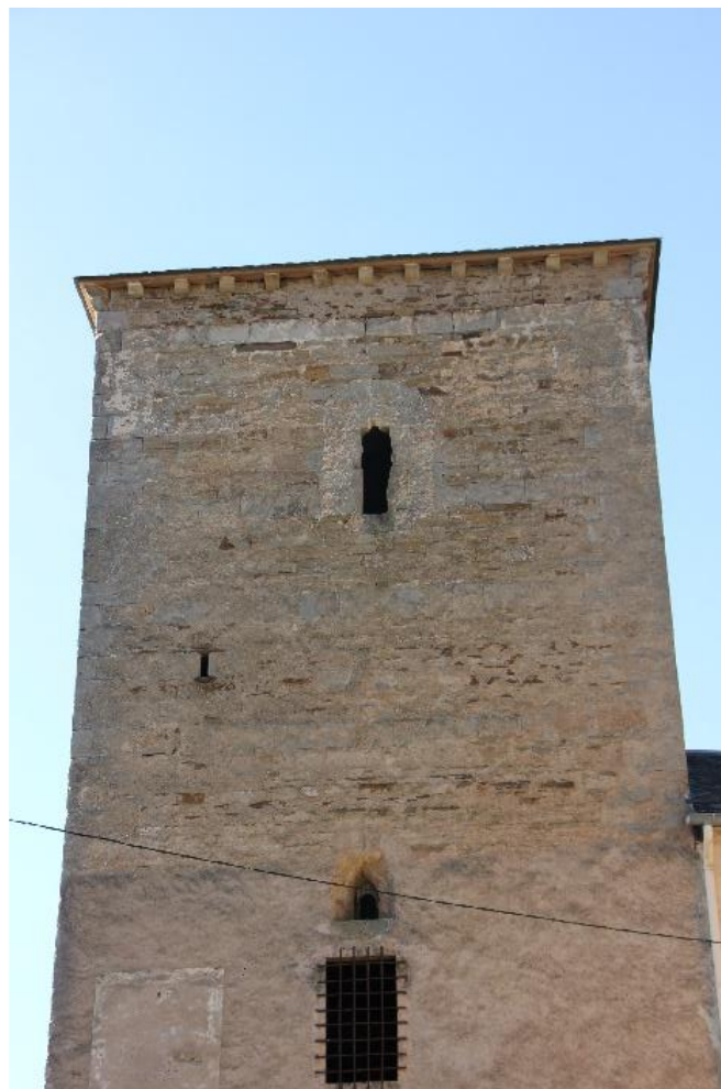
Fig.6 Façade sud de la tour. L'ouverture supérieure correspond à la magnifique baie intérieure ci-dessous. L'ouverture grillagée date du 19 ème siècle et correspond à l'élargissement d'une baie du 12 ème siècle. La petite ouverture située près de l'arête gauche éclaire un escalier en colimaçon
