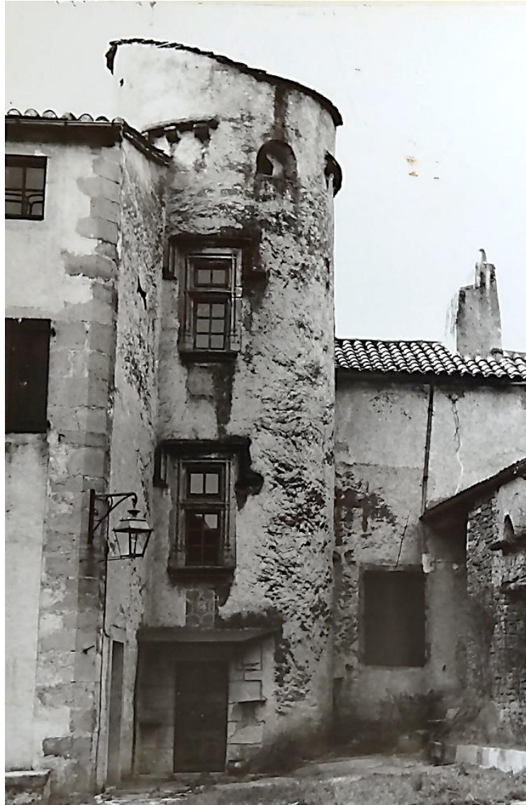
Fig.25 Tourelle escalier du repaire de Candau. Cette belle visette est surmontée d'un pigeonnier soutenu par un rang de corbeaux de grès. Cliché du fonds Balsan, collection de la Société des lettres, sciences et arts de l'Aveyron, 9 novembre 1946. Le style des deux ouvertures à meneau de la visette permet de dater cet aménagement du 16 ème siècle.
