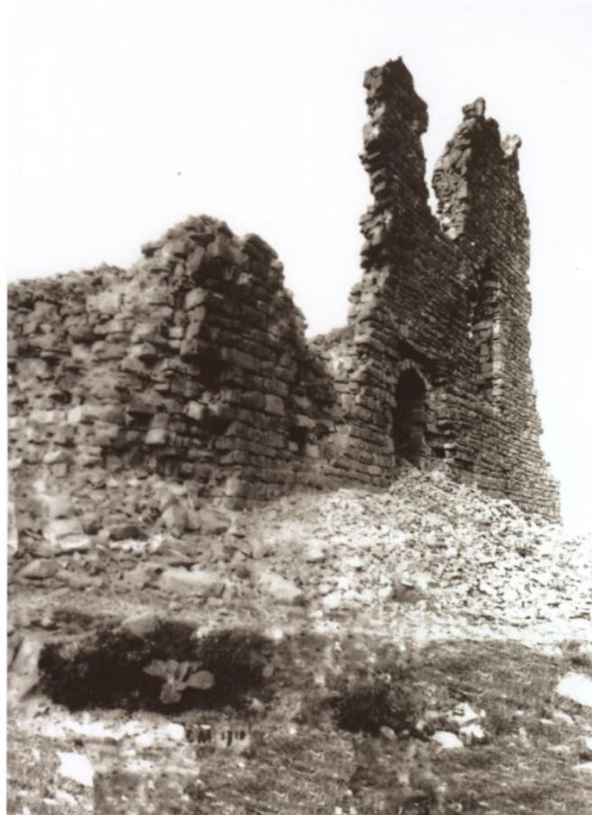
Fig.28 Sur ce cliché de la collection Rouquet, datant des années 1910/1920, on voit encore le mur sud de la tour avec une belle élévation conservée même si l'on perçoit bien leur extrême fragilité (photo collection Robert Rouquet, Montjaux).
