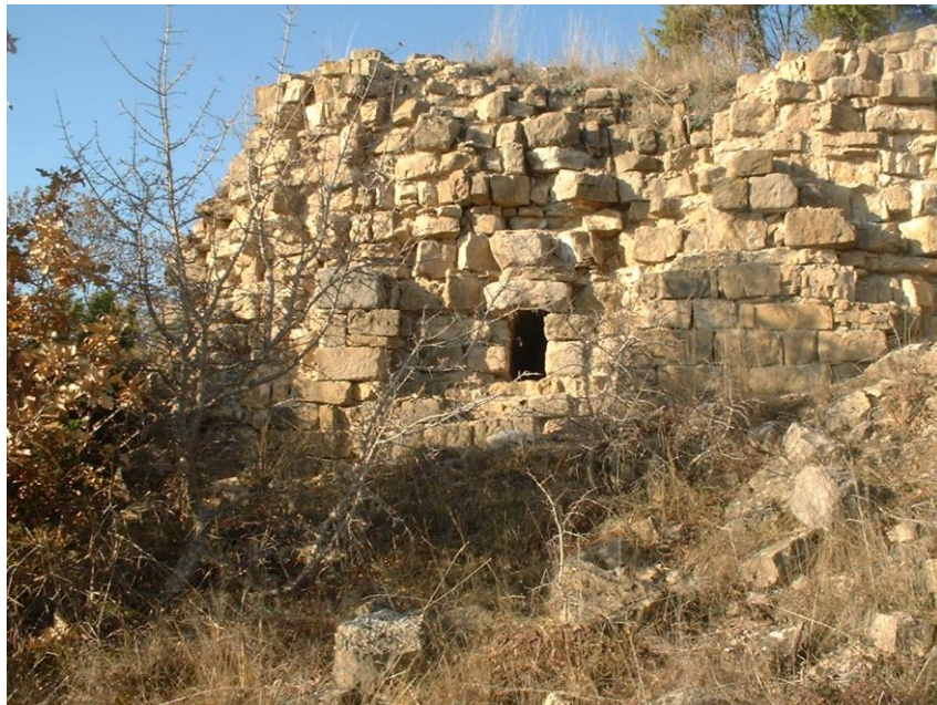
Fig.29 Sur ce mur sud de la tour, on voit encore quelques blocs de grès qui composaient le parement externe en appareil régulier. Beaucoup ont été arrachés, mettant à nu la structure interne des murs composée de cailloutis calcaires liés par un mortier de chaux (photo Alain Bernat, 2000).
