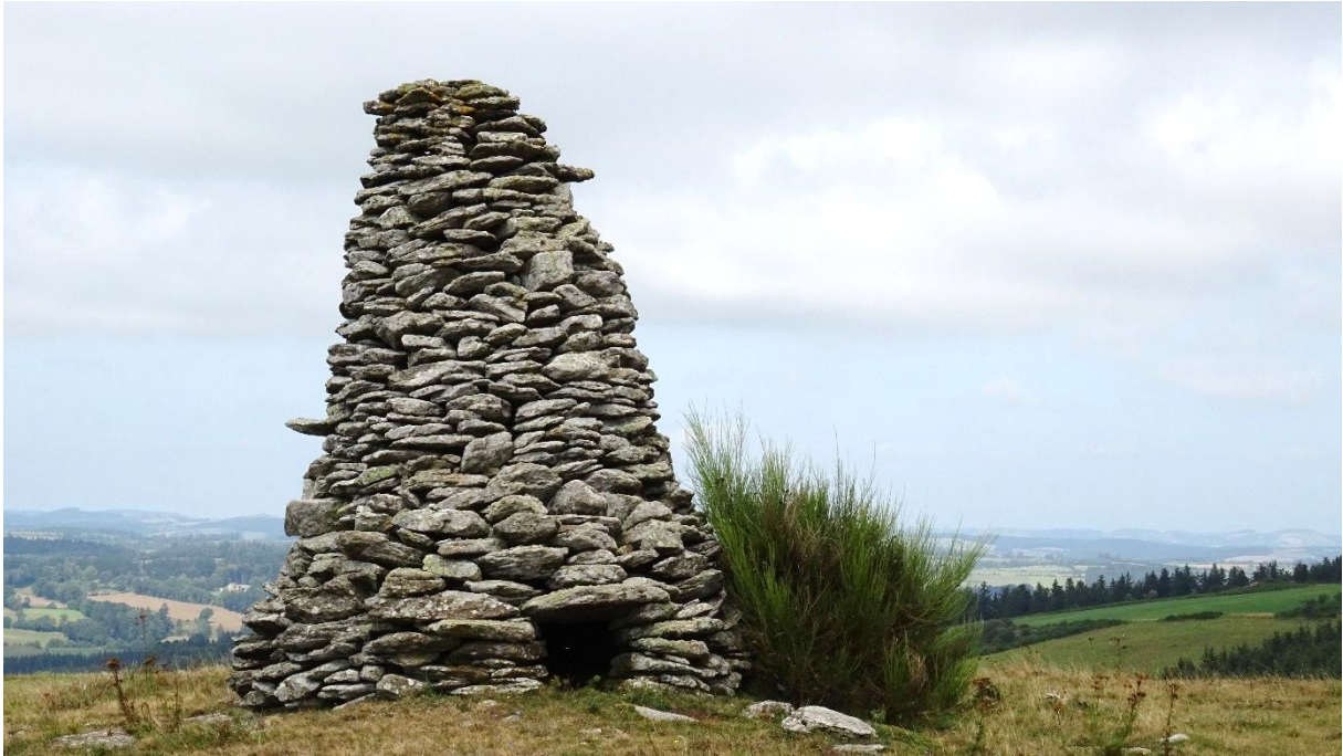
Fig. 6 Quille construite dans les années 1930 par Hervé Gaubert lors de vacances à Candadès pendant lesquelles il faisait berger. Elle est bâtie au point culminant, à 1083 mètres. Très originale par sa structure qui, là aussi, constitue un vrai défi : elle est en partie creuse à l'intérieur. Heureusement élevée sur le substrat rocheux, et si elle porte fièrement ses 80 ans, elle n'en demeure pas moins très fragile.
